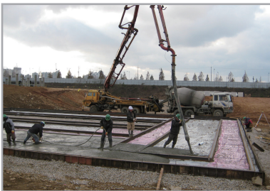
④ 기초콘크리트 타설
