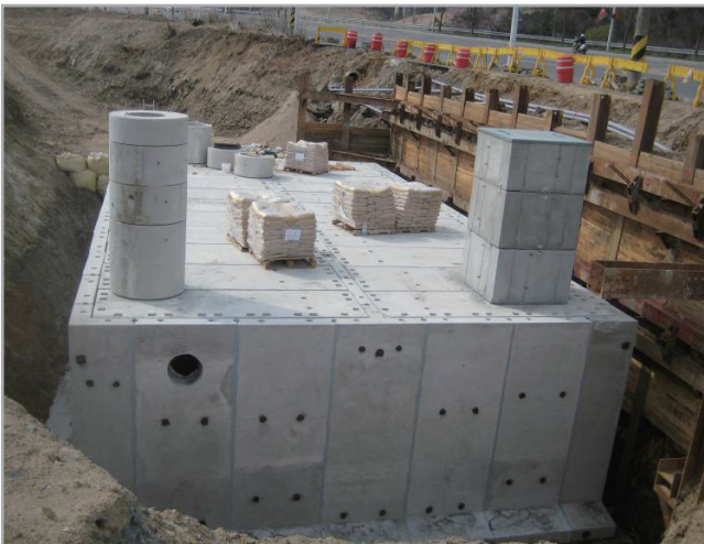
▲ 조립완료 전경 (점검구 맨홀설치 포함)
