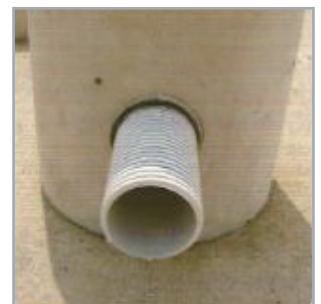
고강도 무수축몰탈 완전충진 상태
