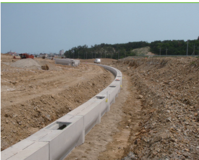
5 되메우기 전 레벨 및 침하 확인
