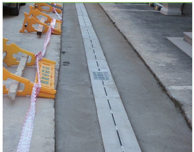
6 되메우기 및 포장
