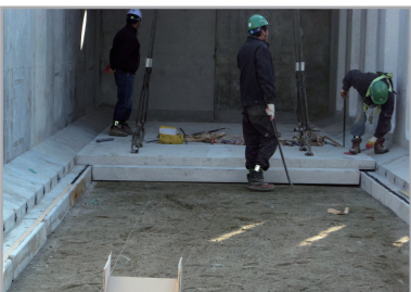
⑩ 하부슬래브 설치
