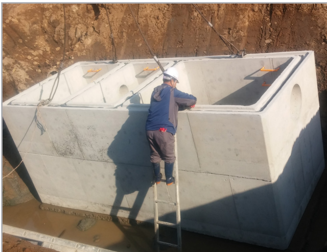
▲ 3련구조 시공 전경
