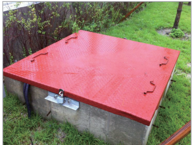
▲ 수중펌프 점검구 맨홀 설치전경
