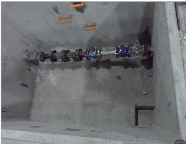
▲ 벨브류 설치 후 전경
