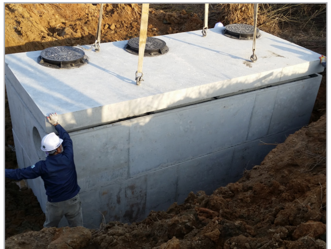
▲ 상부블록 인상 전경
