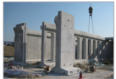
⑨ 내부부재 설치
