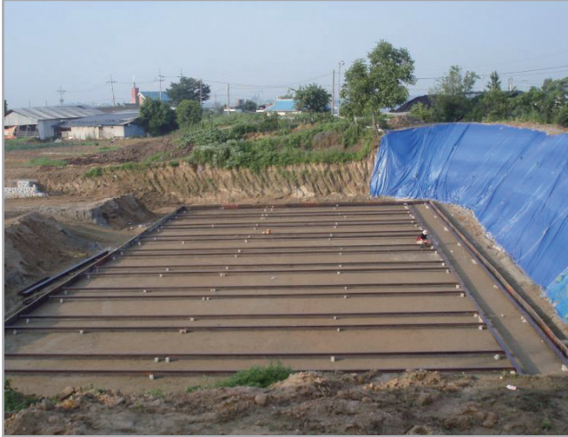
▲ H형강 부설완료 전경
