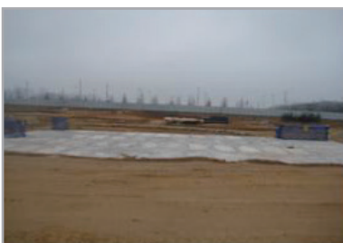
⑬ 부속시설 설치 후 되메우기
