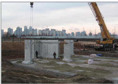
⑦ 벽체부재 설치
