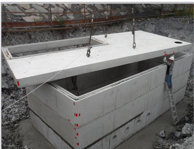
▲ 저수조 시공 전경
