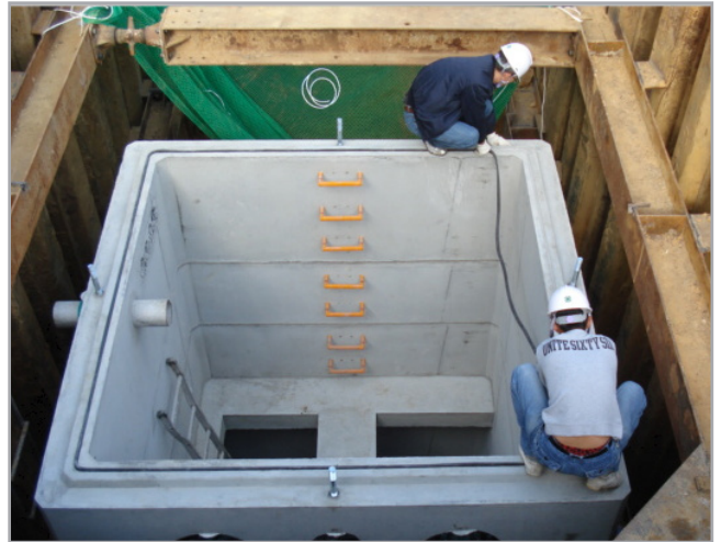
▲ 기계실 시공 전경
