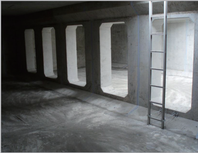
▲ 일체형사다리 설치 및 내부전경
