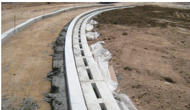
▲ 앵글 설치전 시공전경
