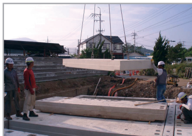
⑪ 상부슬래브 설치
