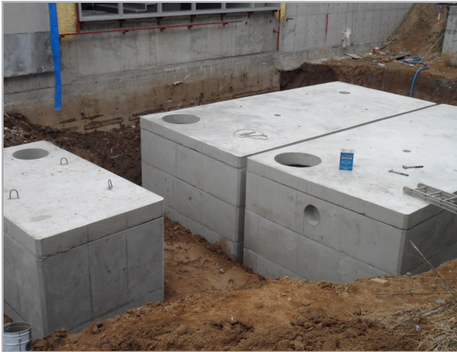
▲ 빗물재이용시설 조립완료 전경
